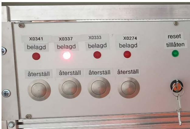
Fig 4. Resetpanel i teknikhuset BFP
